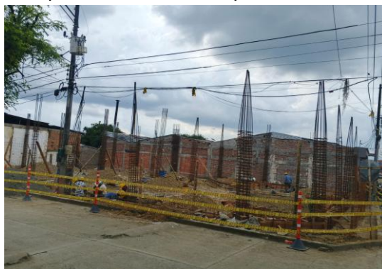
Avance de la obra
